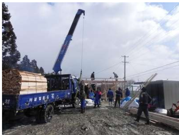
塩たき釜・鮭に燻製の仮設上屋組み立て
